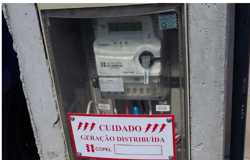
Figura 23 - Medidor Bidirecional
