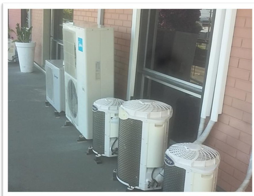
Figura 2 - Condensador do ar condicionado após a retirada do telhado Fonte: O autor, 2018.
