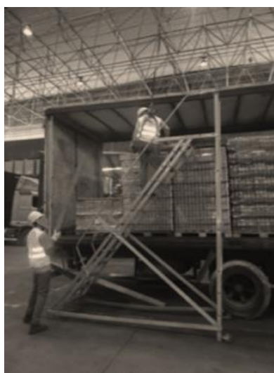
Figura 5 - Remoção de cantoneira com uso de escada e equipamentos de segurança para trabalho em altura Fonte: O autor, 2018.
