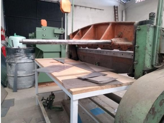
Figura 7: Área das Facas antes da adaptação
