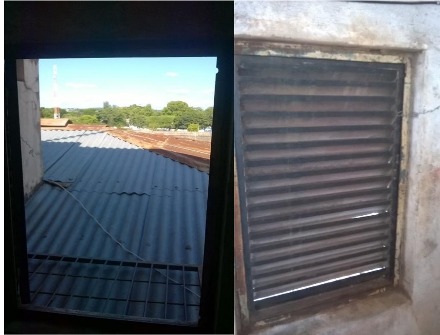
Figura 9: Acesso ao telhado Fonte: o Autor (2018).
