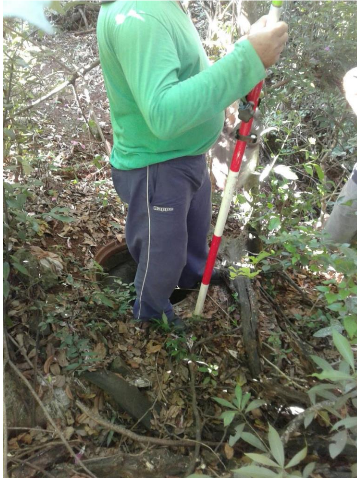
Figura 14: Poço de visita sem tampa Fonte: o Autor (2018).
