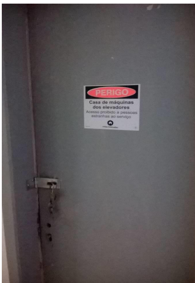
Figura 7: Porta de acesso à casa de máquinas Fonte: o Autor (2018).
