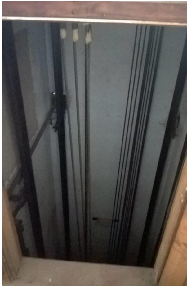
Figura 8: Fosso do elevador exposto Fonte: o Autor (2018).
