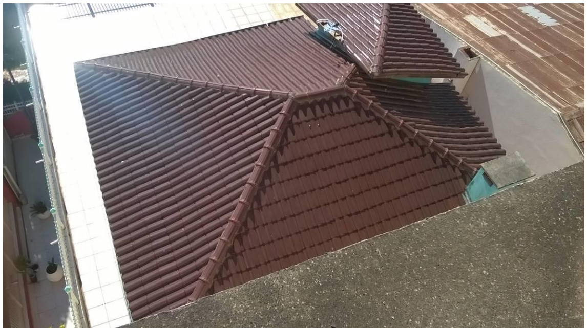
Figura 10: Vista sob o teto da casa de máquinas Fonte: o Autor (2018).
