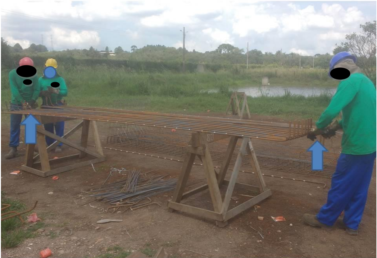
Figura 07 - Armadores durante a tarefa de armação de peças na bancada
