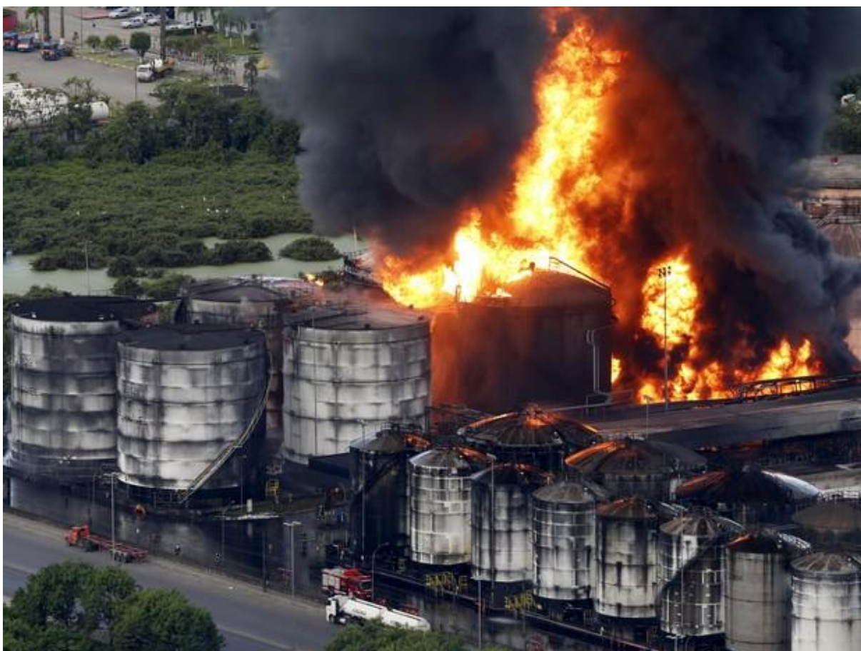
Figura 8 – Incêndio em Santos - SP. Fonte: (G1, 2015)
