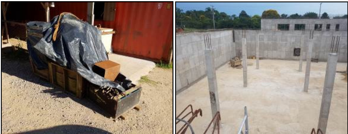
Figura 22 - Ordem e Limpeza – Materiais Estocados e vias da obra desobstruídas – Obra 2 Fonte: o autor
