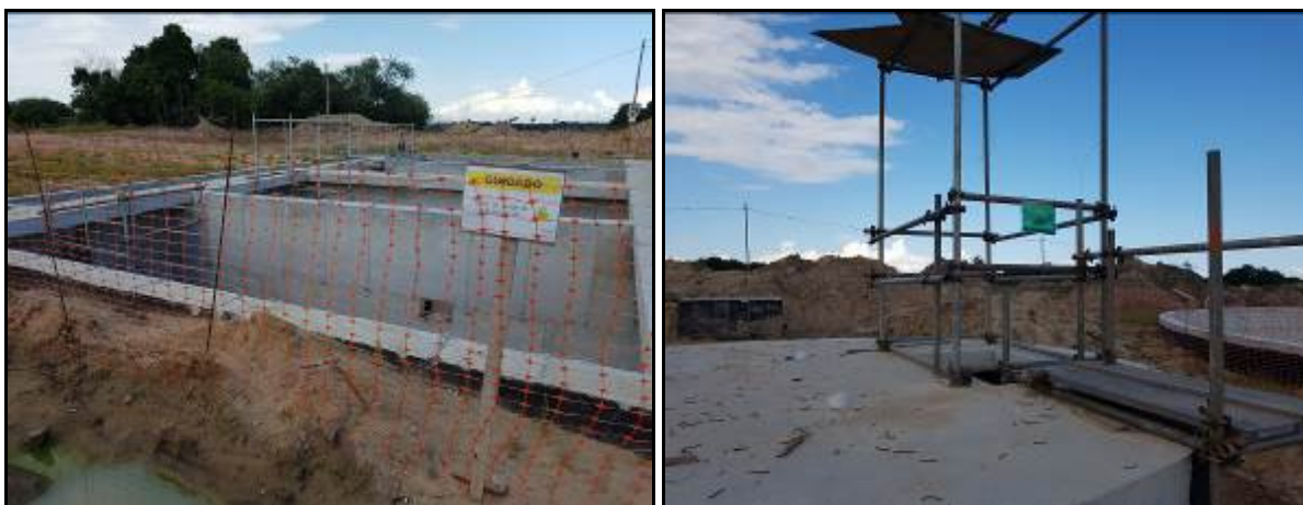
Figura 15 - Proteção contra quedas – estação enterrada e abertura no piso – Obra 2 Fonte: o autor
