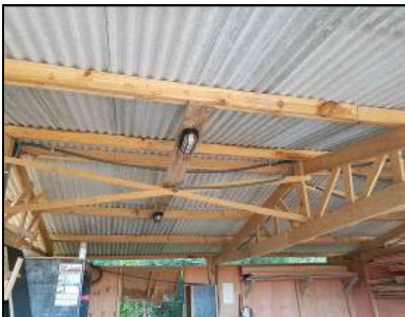
Figura 9 - Carpintaria – iluminação com proteção - Obra 2 Fonte: o autor
