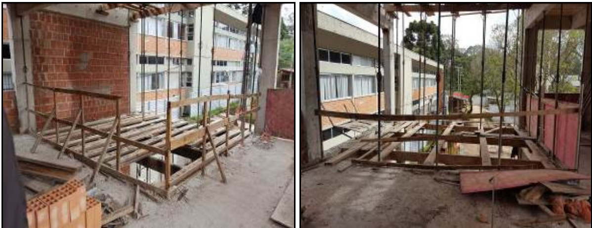
Figura 12 - Proteção contra quedas – 1º e 2º andares – Obra 1 Fonte: o autor
