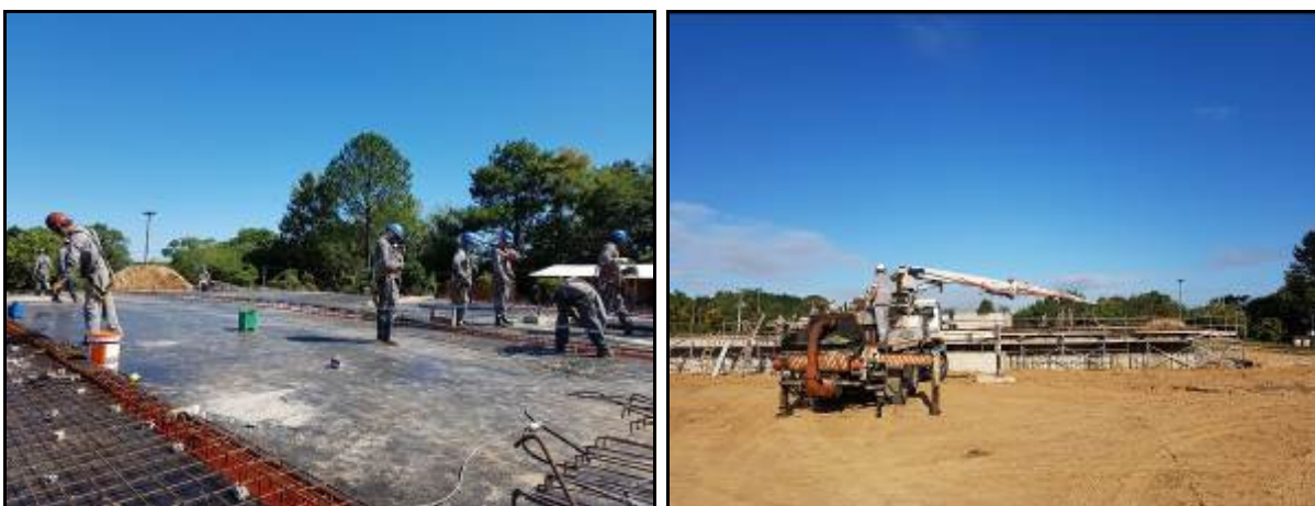
Figura 23 - Ordem e Limpeza – Área de trabalho limpa e sobras organizadas em baldes e vias desobstruídas – Obra 2 Fonte: o autor
