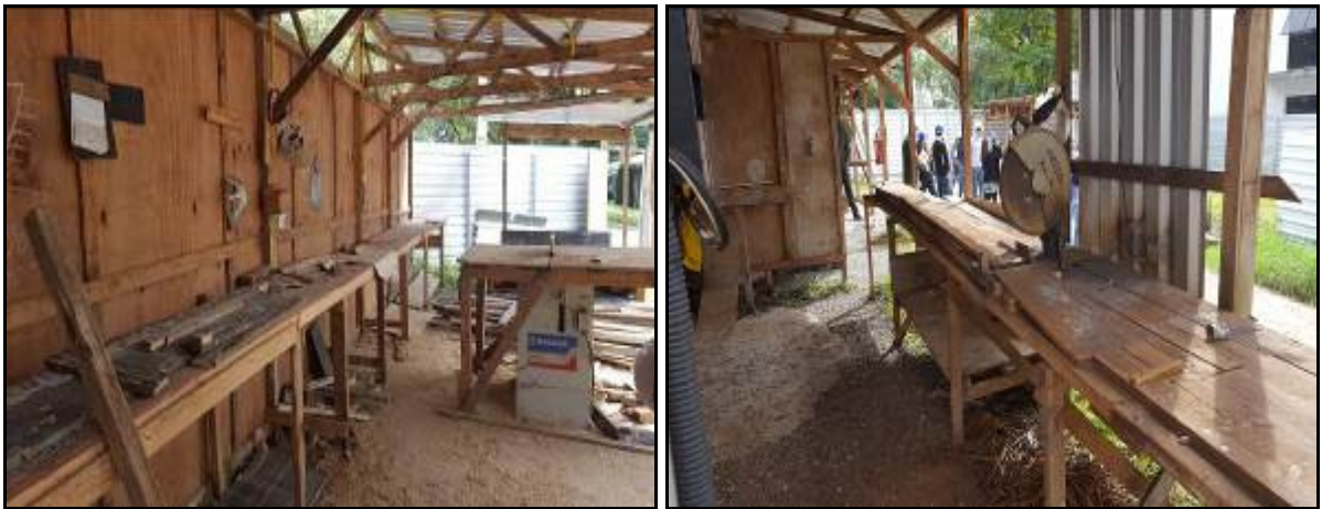
Figura 6 - Carpintaria e Serra circular – Obra 1
