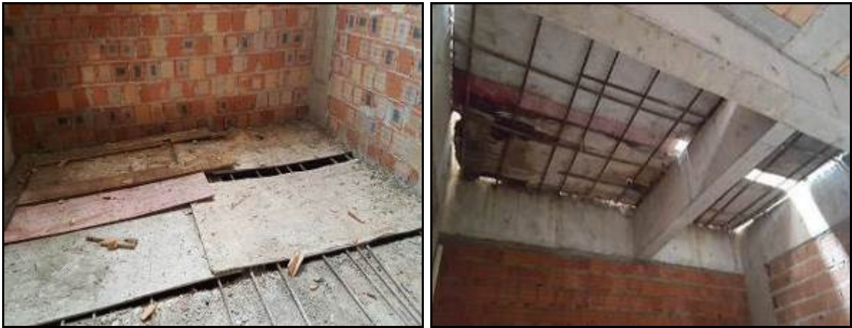
Figura 11- Proteção contra quedas – fosso do elevador – Obra 1 Fonte: o autor
