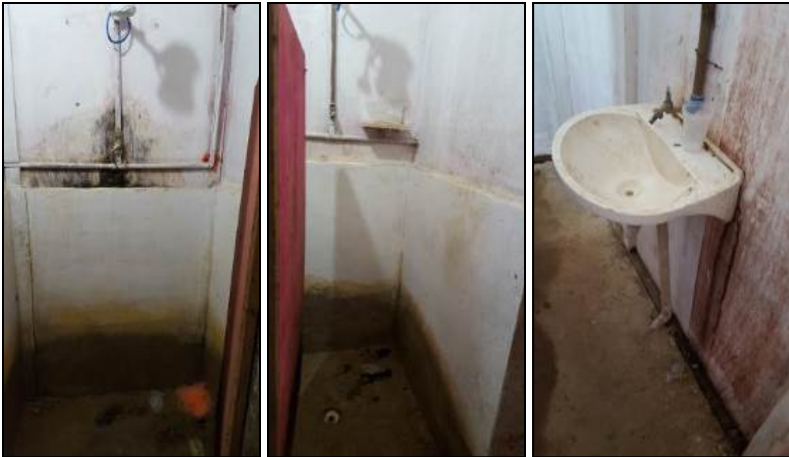
Figura 2 - Instalações Sanitárias – Box dos chuveiros e lavatórios – Obra 1 Fonte: o autor
