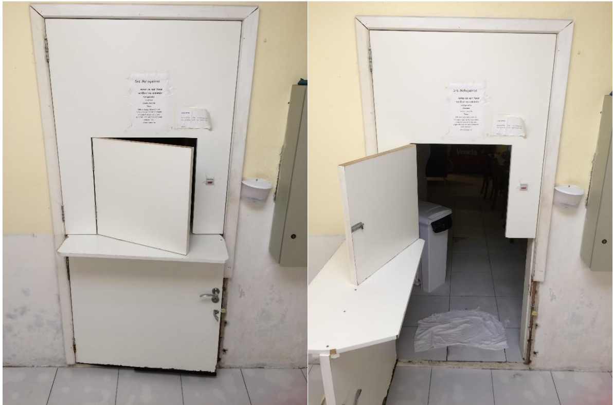
Figura 6 – Porta-balcão fechada (à esquerda) e aberta (à direita) Fonte: Autoria própria
