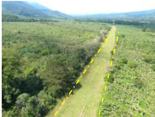
Figura 17 - faixa de dutos em área rural. Fonte: Arquivos Transpetro (2017) 7 .
