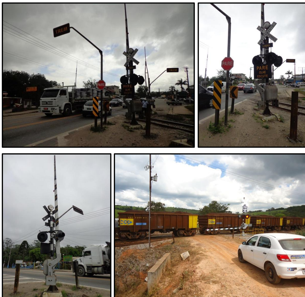
Figura 23 – Detalhes de cancelas automáticas com sinalização audiovisual.
