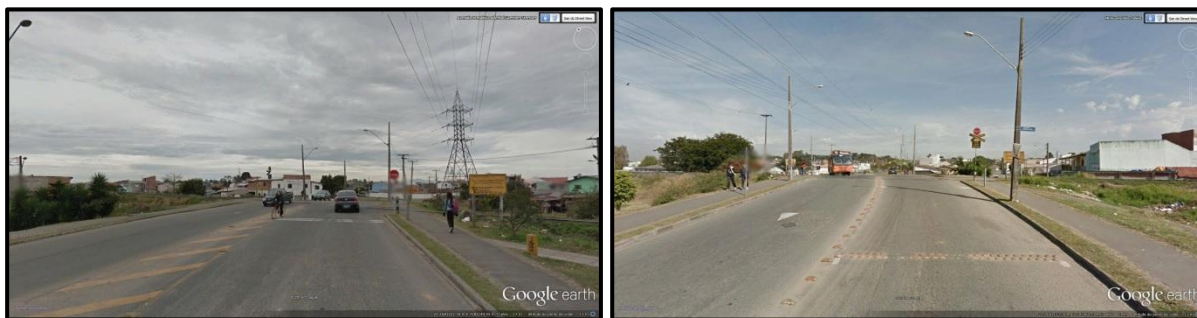
Figura 17 – Vistas da PN do km 105,450 sentido leste (esquerda) e sentido oeste (direita).
