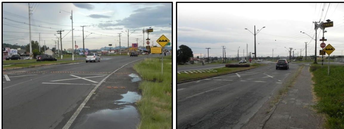
Figura 21 – Detalhes da sinalização horizontal, de redutores de velocidade e dos canteiros centrais existentes, sentido Piraquara (à esquerda) e sentido Curitiba (à direita).
