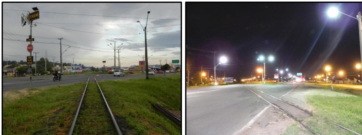
Figura 18 – Vista da PN pelo trilho, sentido Paranaguá, com detalhes do equipamento de proteção (à esquerda) e detalhes da iluminação eficiente e pavimento regular (à direita).
