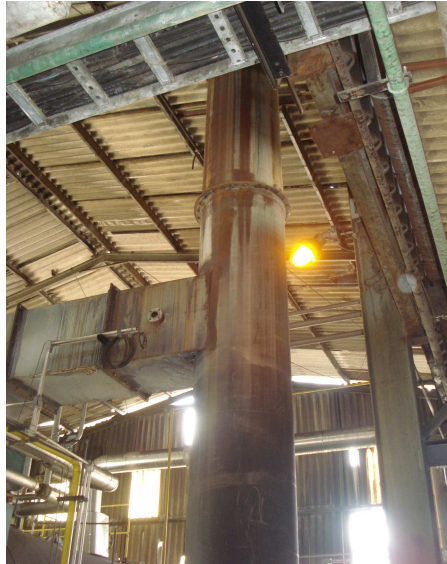
Figura 25: Sistema de iluminação – Caldeira TNG GV - 405.
