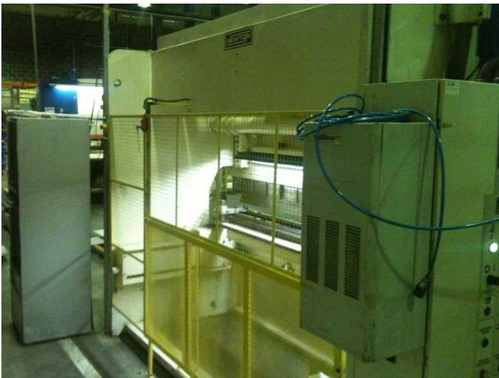
Figura 12. Vista traseira da máquina após adequação. Fonte: O autor.
