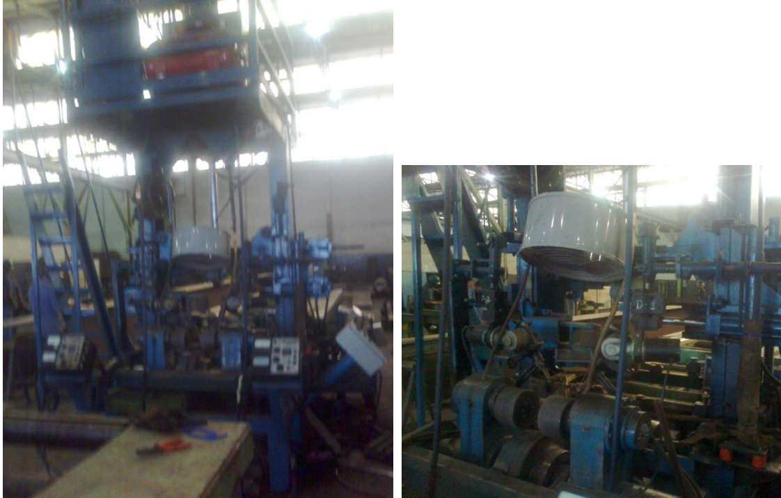
Figura 7 – Equipamento de arco submerso. Exaustor instalado na estrutura do equipamento.
