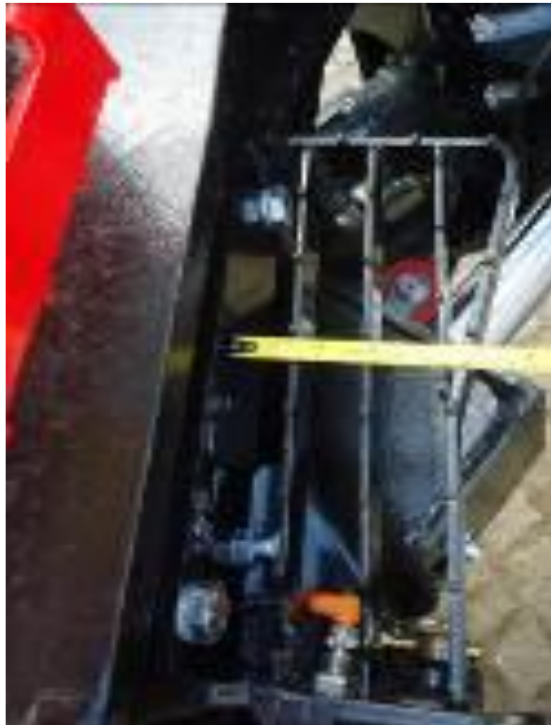
Figura 11: Degrau da plataforma de manutenção Fonte: O autor (2017).
