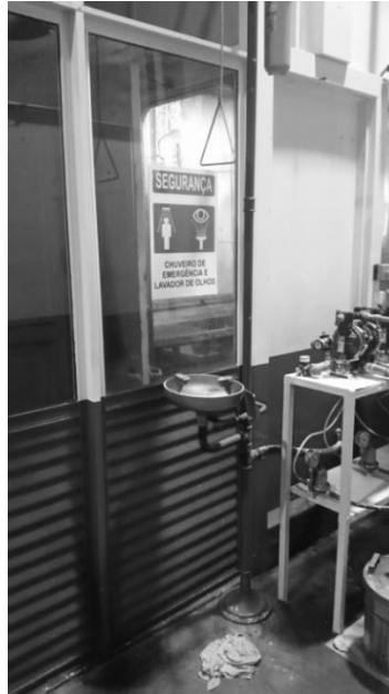
Figura 12: Chuveiro lava olhos e Chuveiro de emergência. Fonte: Autor (2018).
