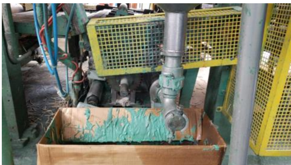
Figura 17: Transbordamento do copo de alimentação. Fonte: Autoria própria (2019).
