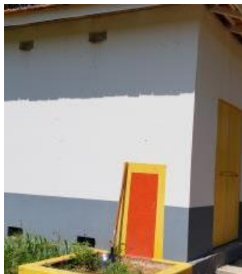
Figura 8: Caixa de areia para combate à pequenos incêndios nos depósitos 2 e 3. Fonte: Autoria própria (2019).
