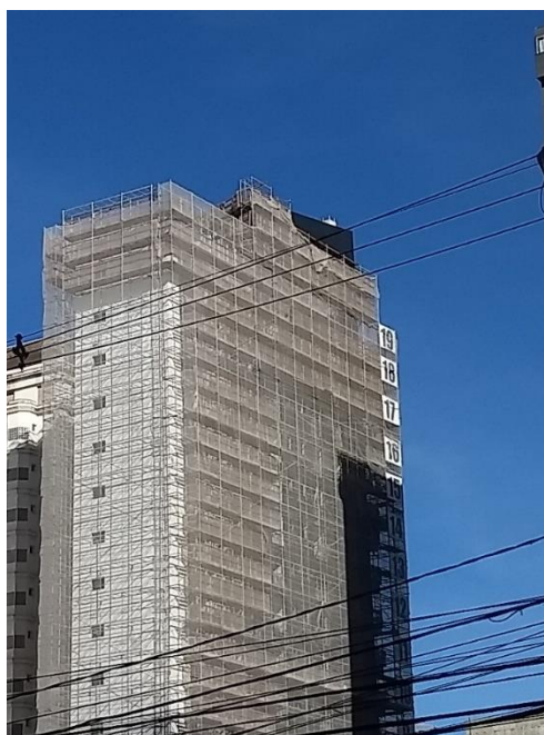
Figura 05: Andaime Fachadeiro – Obra Edifício Múltiplos Pavimentos
