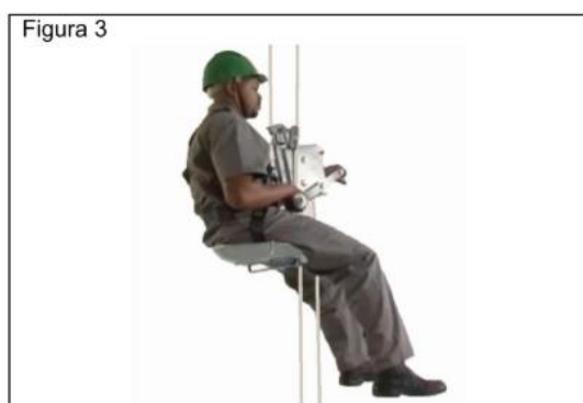
Figura 03: Acesso por Cadeira Suspensa.
