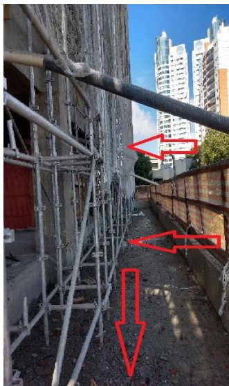
Figura 07: Andaime Fachadeiro (Tela na Fachada e Apoio Direto Sobre a Estrutura)
