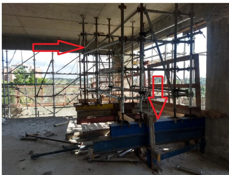
Figura 06: Base do Andaime Fachadeiro em Balanço
