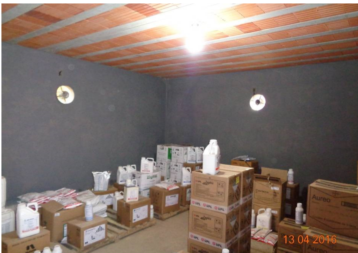
Figura 16 - Depósito com ventilação mecânica Fonte: O Autor.
