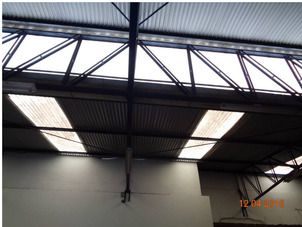
Figura 11 - Telhas translúcidas Fonte: O Autor.
