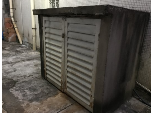
Figura 9 – Local de instalação do compressor de ar.
