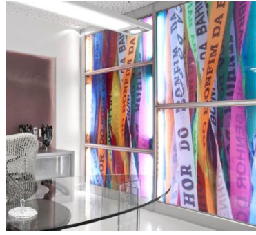
Figura 14. Painéis impressos em tecido com proteção em vidro, usados em divisórias. Fonte: Vidrado, 2012
