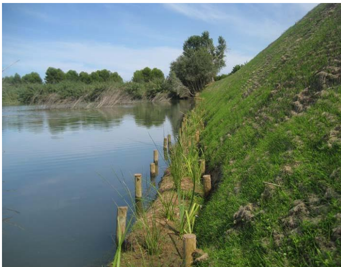
Figura 23 - SISTEMA DE BORDAS PROJAR COM FIBRA DE COCO Fonte: PROJAR © (2015)
