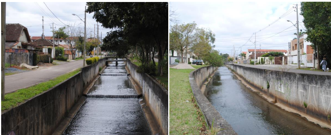
Figura 5 - CANALIZADO À CÉU ABERTO
