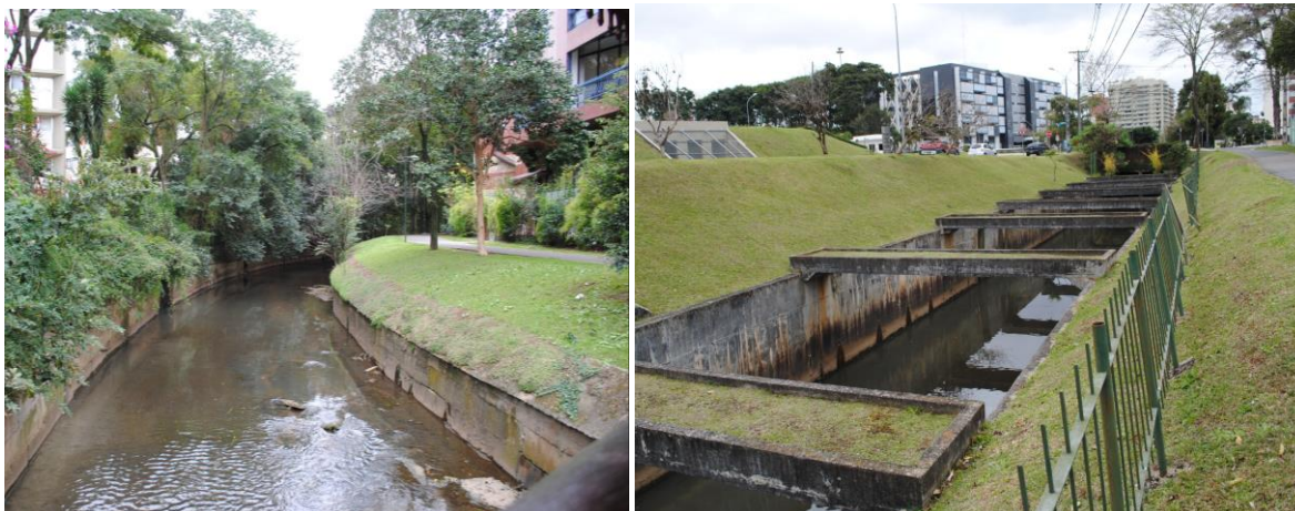
Figura 6 - RIO BELÉM E EDIFÍCIO JUNTO AO ALINHAMENTO PREDIAL
