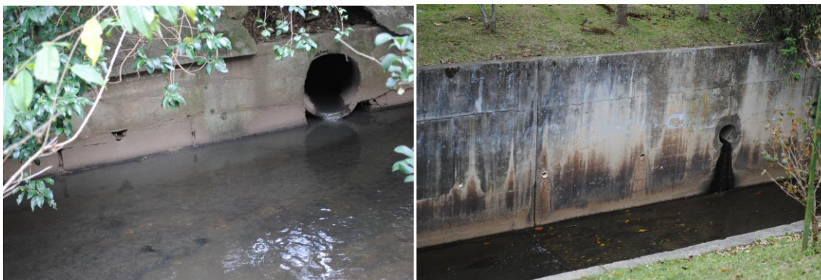
Figura 9 - TUBULAÇÃO DE ESCOAMENTO DE AGUAS PLUVIAIS Fonte: Autoria própria (2015)
