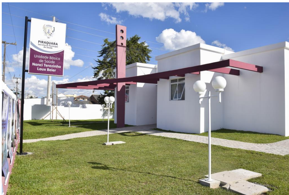
Fotografia 1 - Fachada UBS Nancy Terezinha Laux Beiler Fonte: http://www.piraquara.pr.gov.br/dbimages/53001.img
