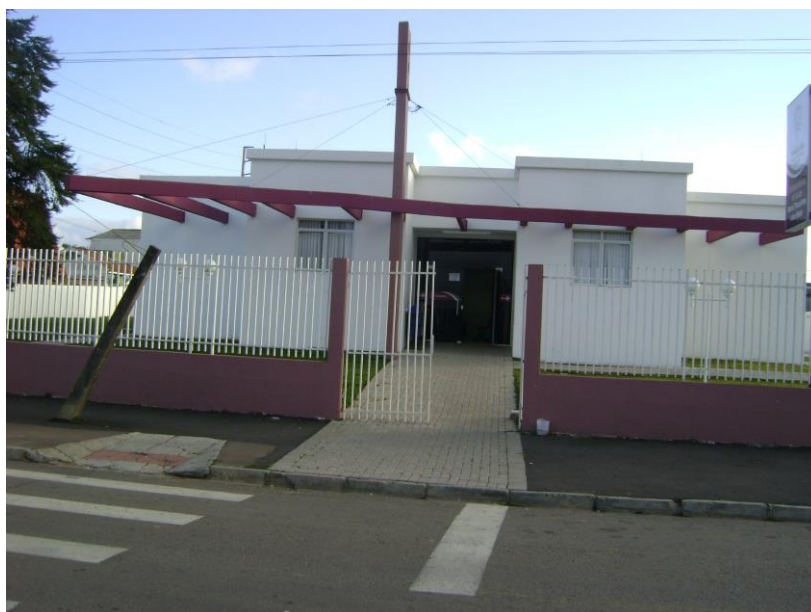
Fotografia 6 – Acesso Principal UBS Nancy Terezinha Laux Beiler Fonte: Autoria própria
