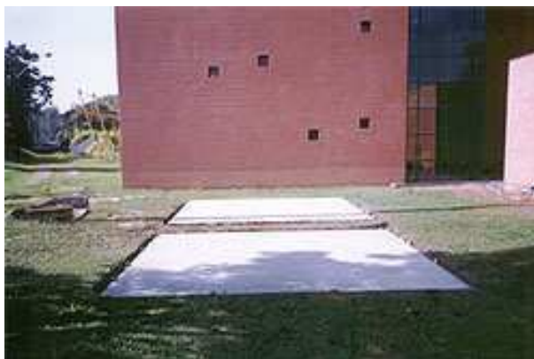
Figura 7 - Vista de uma laje radier concluída Fonte: TECHNE, 2010).
