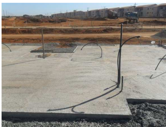
Figura 6 - Detalhe da execução de um radier Fonte: MULTIBUILDING, 2015).
