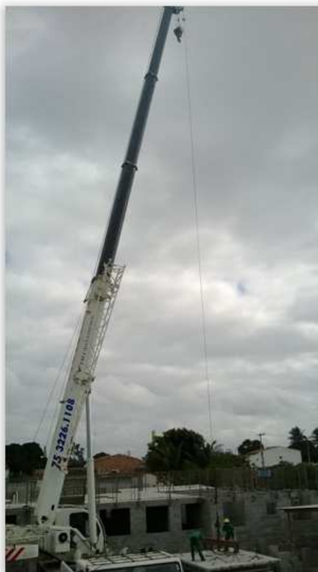
Figura 9 - Içamento laje içada
