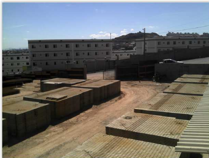
Figura 3 - Pista laje içada
