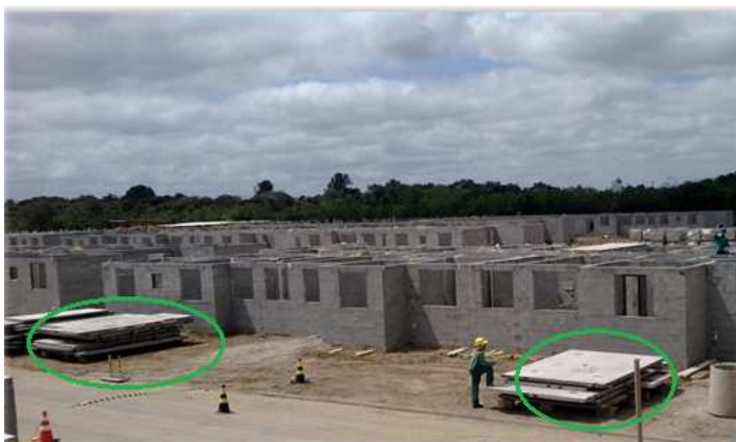
Figura 7 - Local do estoque das lajes para içamento
