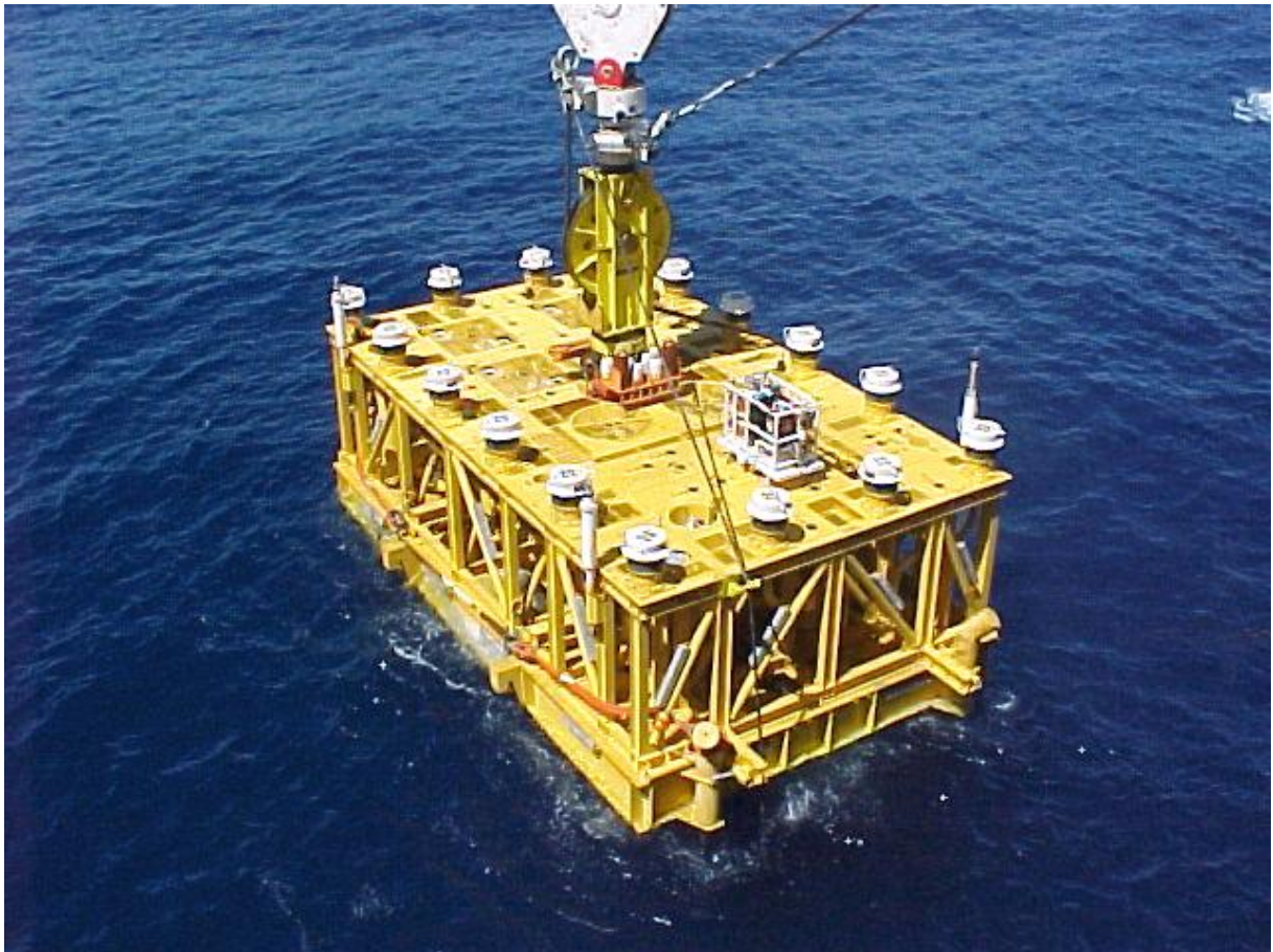
Figura 4—Manifold submarino sendo instalado no campo de Roncador Fonte: FMC Technologies (2002)
