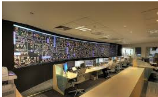
Figura 2 – Centro de Operação do Sistema e Distribuição - COS. Fonte: AES Eletropaulo.
