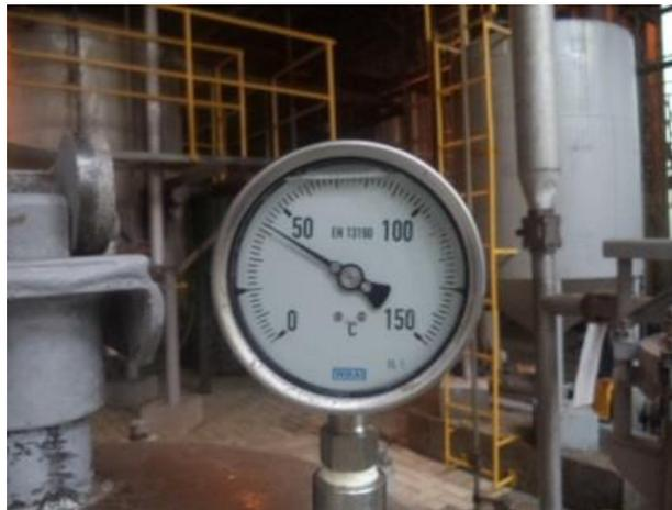
**Figura 27 – Termômetro da etapa de filtragem (polimento) do óleo refinado de soja**
