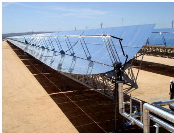
Figura 3 – Coletor solar cilíndrico.
