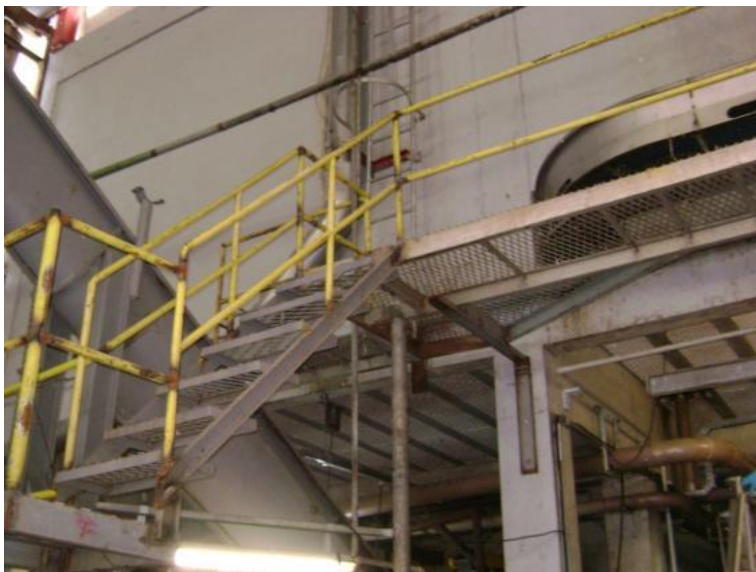
Figura 27: Escada de acesso à plataforma maior Fonte: Autoria própria
