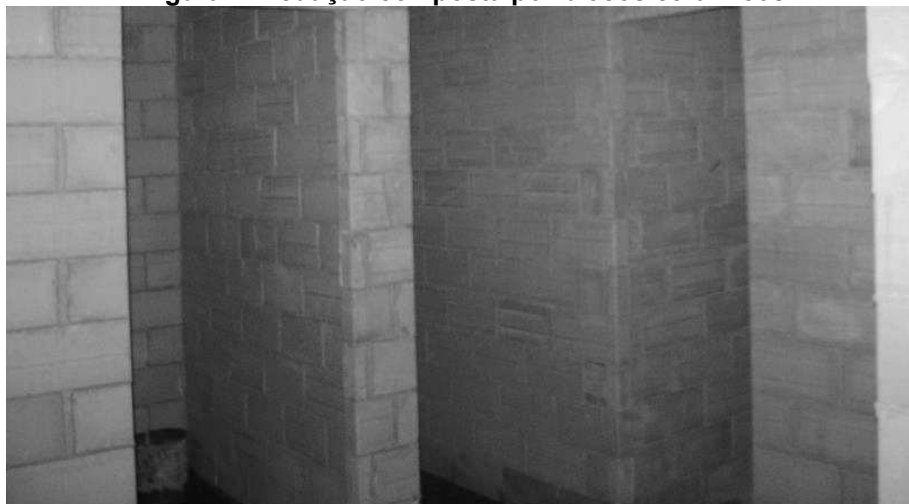
Figura 1: Vedação composta por blocos cerâmicos
