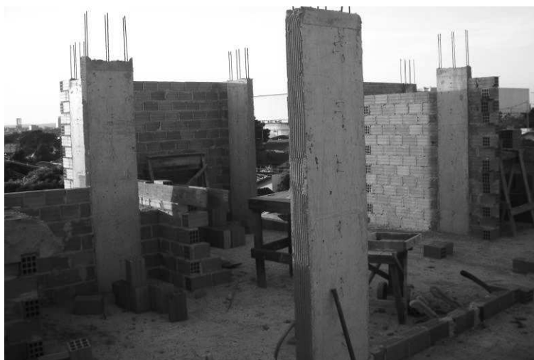
Figura 7: Serviço de alvenaria executado em obra.
