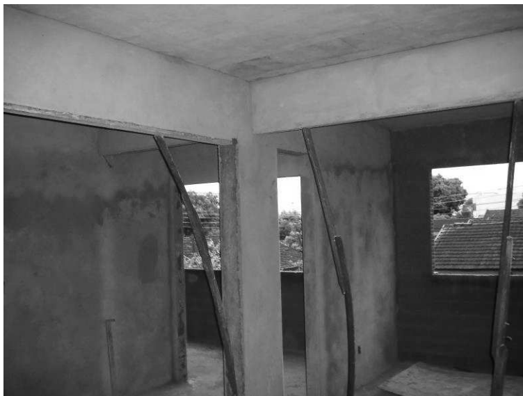
Figura 13: Serviço de emboço executado em obra.
