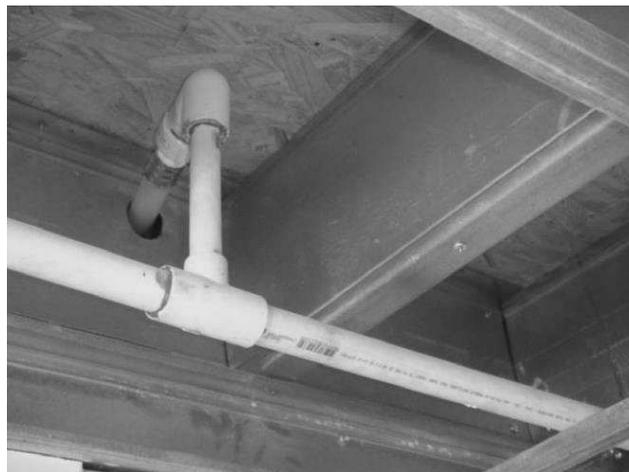
**Figura 15 – Tubulação de PVC com passagem em perfil que compõe laje**
