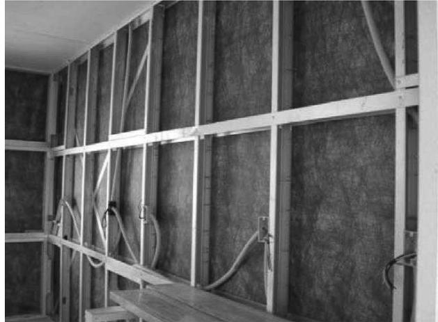
**Figura 16 – Conduítes de fiação elétrica**
