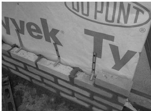
**Figura 18 – Fechamento de alvenaria em LSF**
