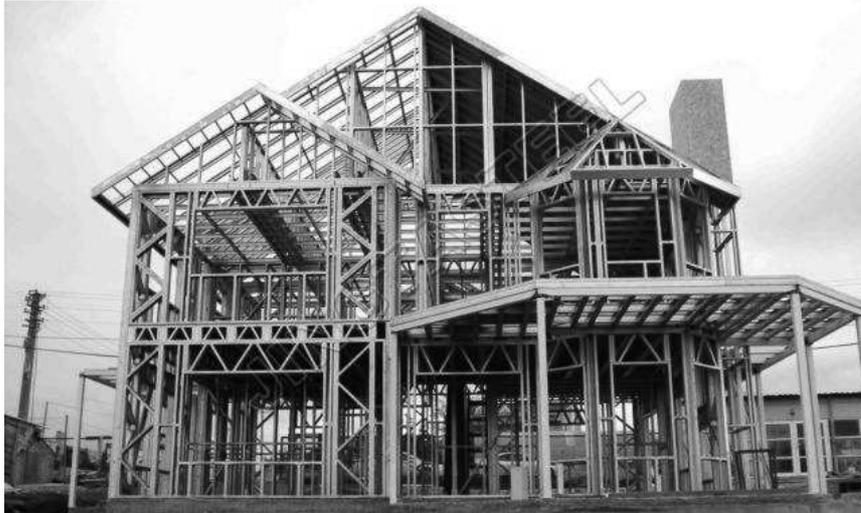
**Figura 1 – Residência construída em sistema LSF**
