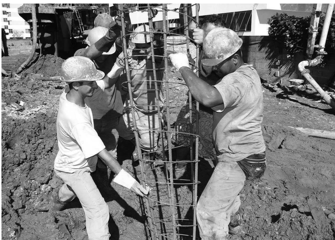
Figura 3: Colocação da armadura.
