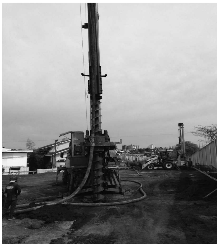
Figura 2: Perfuração de uma Estaca Hélice Contínua sobre caminhão. Fonte: FUNGEO Fundações e Geologia.
