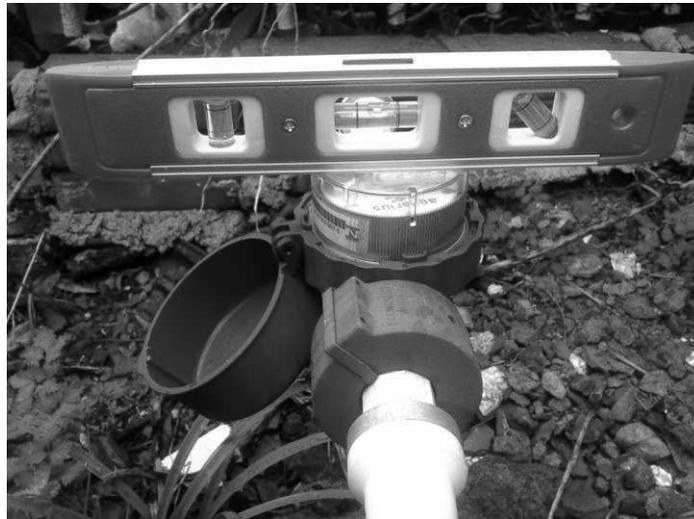
**Figura 23 - Aferição da horizontalidade do medidor com nível de bolha.**
