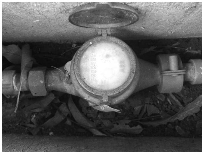
**Figura 39 - Hidrômetro com visor embaçado.**
