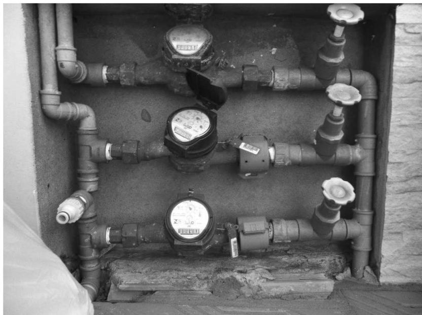
**Figura 28 - Ligação embutida em parede com hidrômetros inclinados.**
