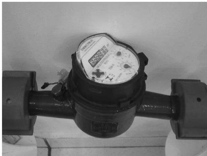
**Figura 15 - Hidrômetro com lacres anti-fraude instalados nas conexões.**
