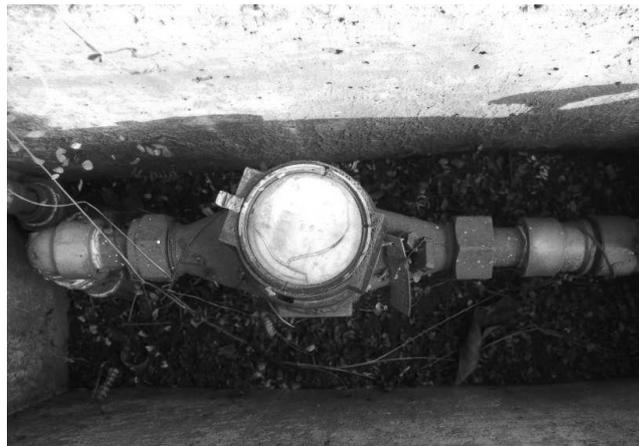
**Figura 40 – Hidrômetro Praça Municipal sem tampa de proteção com visor embaçado e danificado.**
