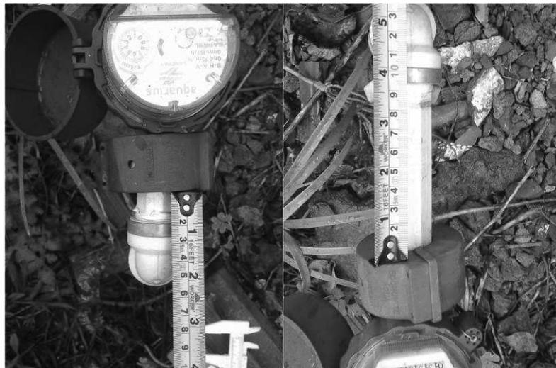
**Figura 26 - Aferição do comprimento da tubulação reta a montante e jusante do hidrômetro.**
