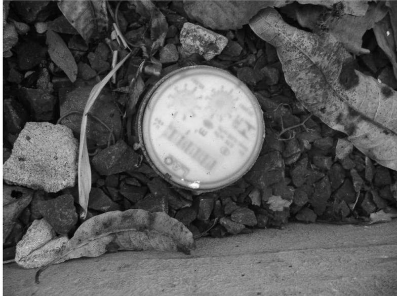
**Figura 27 - Hidrômetro parcialmente enterrado.**
