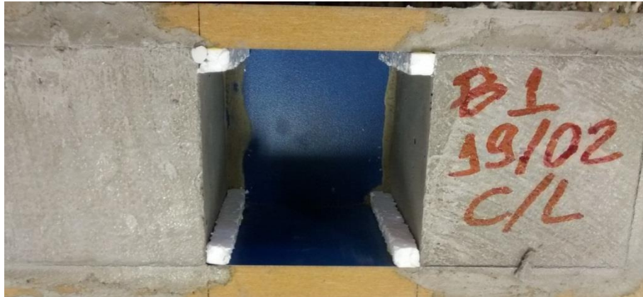
Figura 13 - Disposição da peça com inserção das tiras de isopor nas paredes da fôrma para a segunda etapa de concretagem das peças Fonte: O autor
