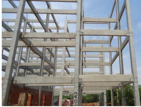
Figura 1 - Estrutura pré-fabricada montada no seu local de utilização
