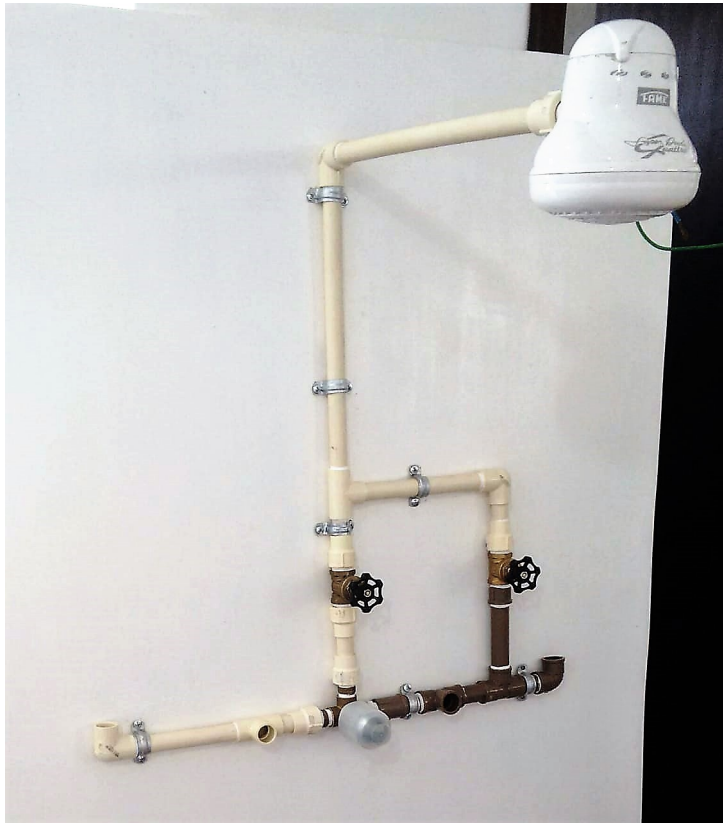
Figura 38: Montagem primária, sistema hidráulico
