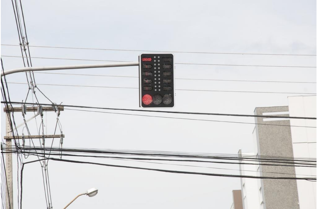
Figura 25 - Semáforo de LED instalado no cruzamento entre as ruas Itabira e Tocantins. Fonte: Autoria própria.
