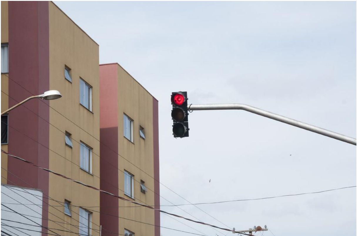
Figura 24 - Semáforo convencional instalado no cruzamento entre as ruas Itabira e Aimoré. Fonte: Autoria própria.
