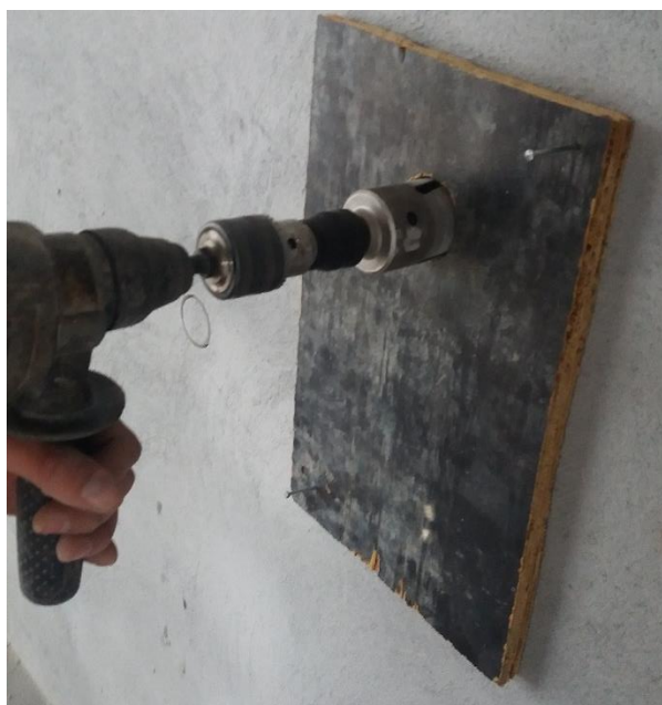
Figura 33 - Corte da parede com serra copo Fonte: Aatoria própria (2017).
