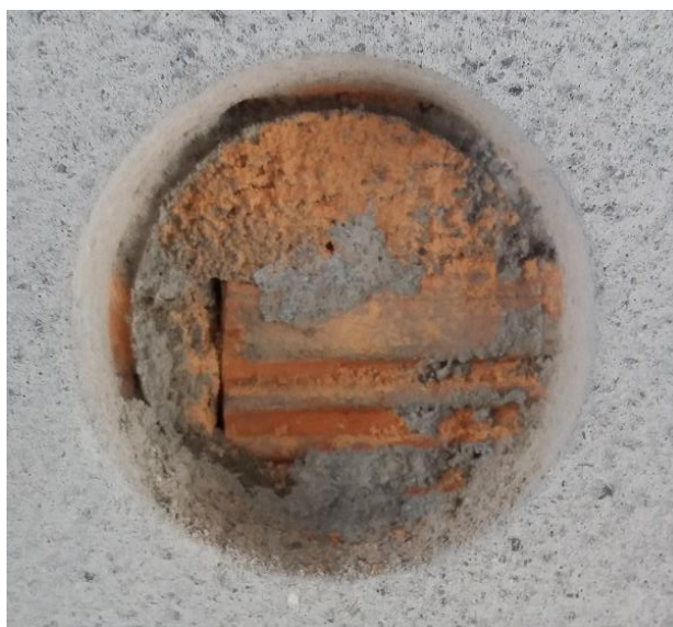
Figura 38 - Rompimento quase totalmente no substrato Fonte: Autoria própria (2017).
