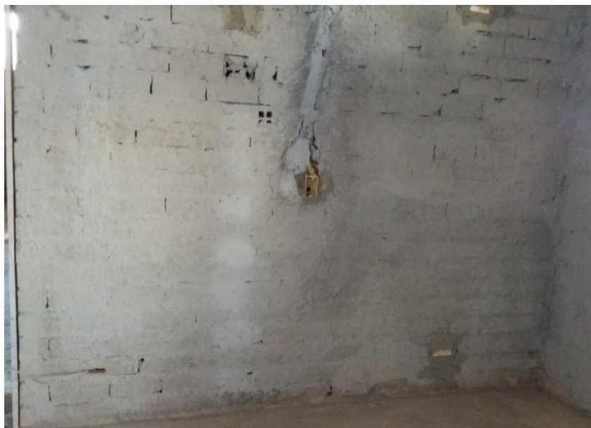
Figura 30 - Parede com chapisco Fonte: Autoria própria (2017).
