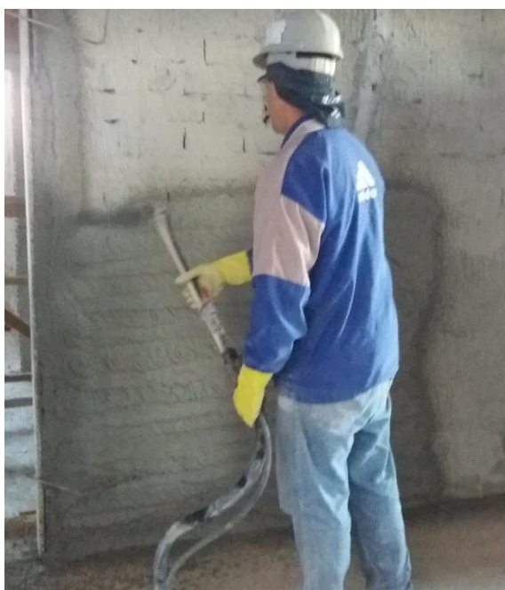
Figura 31 - Projeção de argamassa de emboço Fonte: Autoria própria (2017).
