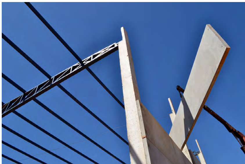
Figura 14: Içamento de uma placa de vedação pré-fabricada Fonte: (MODULAR ENGENHARIA, 2009)
