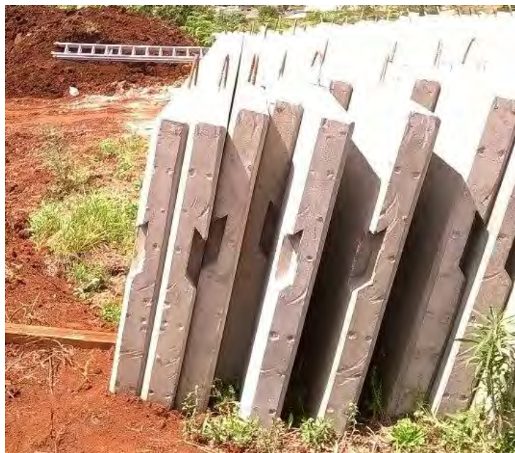
Figura 38: Armazenamento de painéis pré-moldados na empresa A
