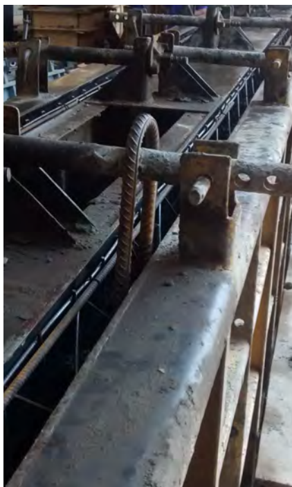
Figura 19: Alça de içamento para painel pré-moldado já colocada no molde na empresa A Fonte: Autoria Própria.
