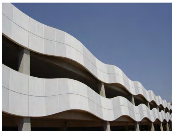
Figura 1: Fachada de edificação com a utilização de painéis pré-fabricados de concreto Fonte: (REVISTA ARQUITETURA E CONSTRUÇÃO WEB, 2011).
