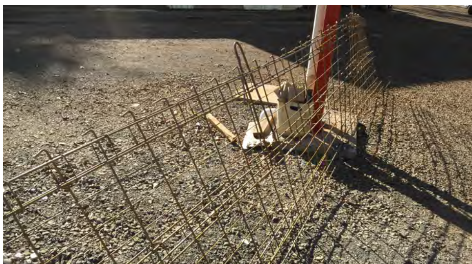
Figura 27: Armadura pronta para ser colocada na fôrma para concretagem na empresa B, sem espaçadores Fonte: Autoria Própria.
