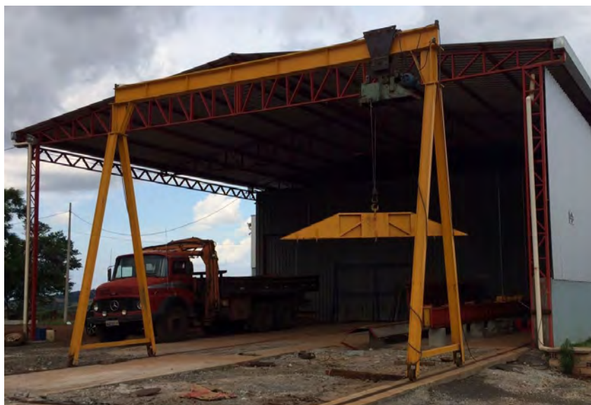
Figura 34: Pórtico utilizado para a suspensão de peças pré-moldadas na empresa B Fonte: Autoria Própria.
