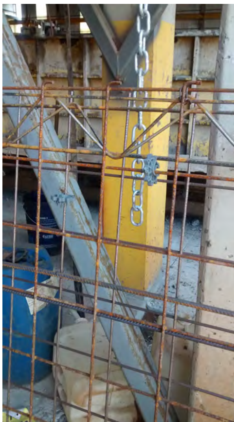
Figura 25: Espaçadores colocados na armadura para garantir o cobrimento mínimo necessário às armaduras. Fonte: Autoria Própria.
