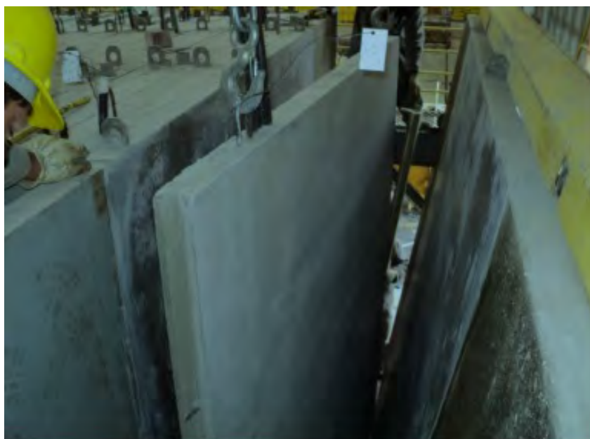
Figura 13: Processo de desfôrma dos painéis pré-fabricados Fonte: (FREITAS, 2011)
