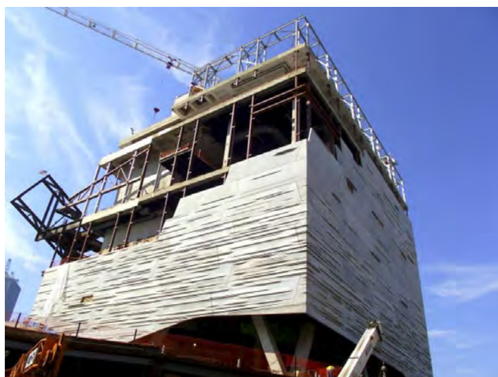
Figura 3: Fachada em construção do Perot Museum Fonte: (BROWN, 2011).
