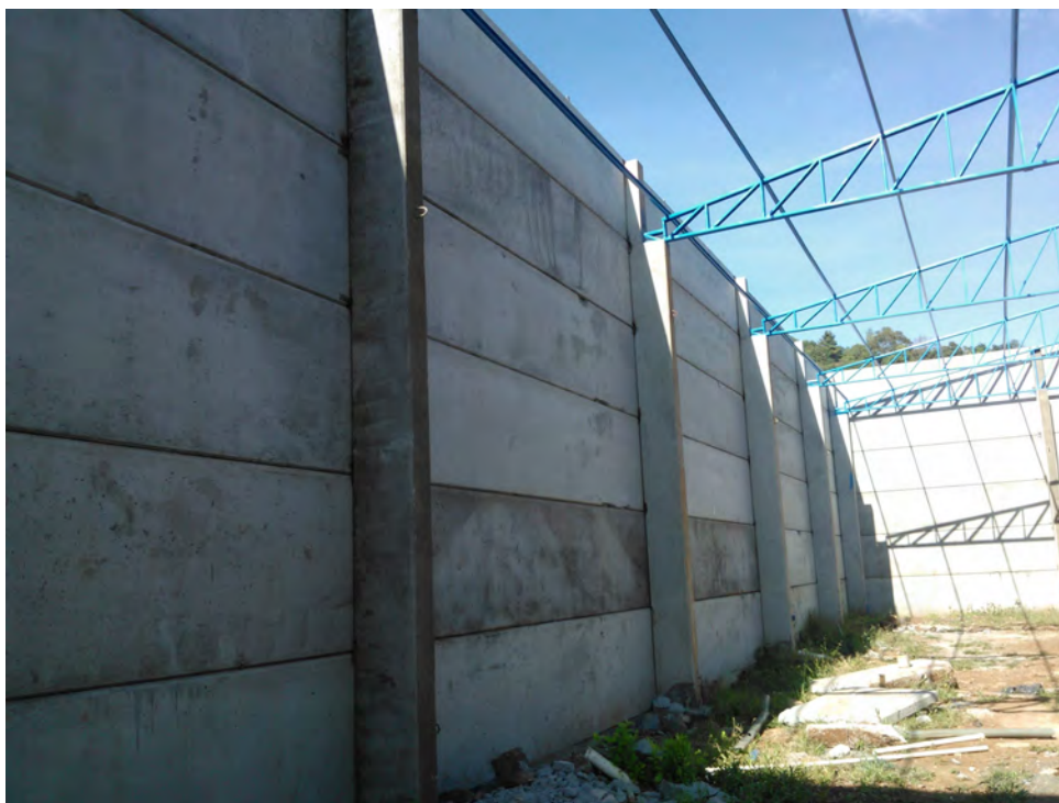
Figura 41: Discrepância de coloração e manchas nos painéis pré-moldados de vedação da empresa B Fonte: Autoria Própria.
