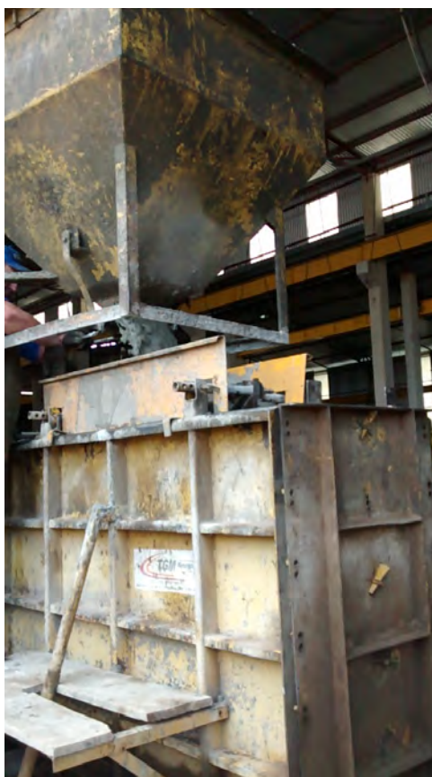
Figura 30: Momento da concretagem de placa pré-moldada de vedação pela empresa A
