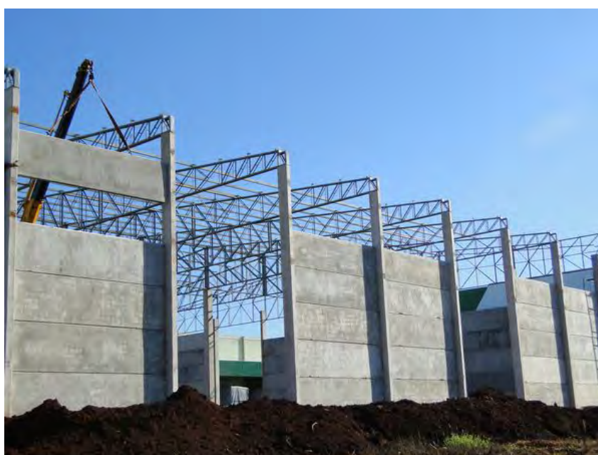
Figura 11: Utilização dos painéis pré-fabricados de concreto em barracões industriais
