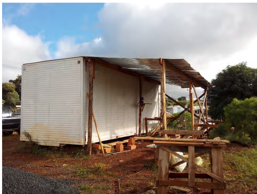
Figura 6 – Carroceria de caminhão baú no canteiro de obras. Fonte: Autoria Própria (2015).
