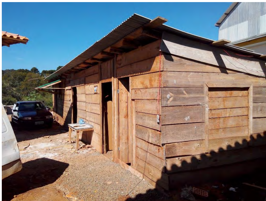
Figura 4 – Instalações provisórias canteiro de obras. Fonte: Autoria Própria (2015).
