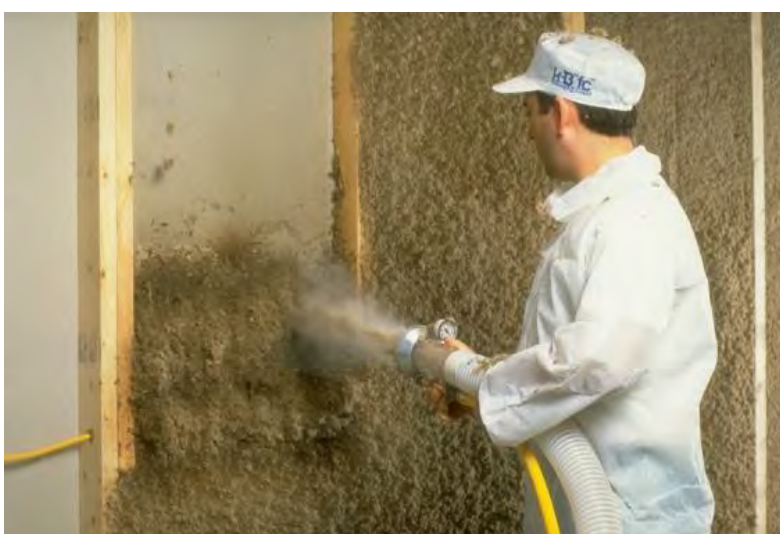
Figura 21– Jateamento de Espuma de poliuretano. Fonte: Site da empresa Celbar. 3
