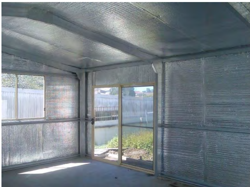
Figura 22– Instalações provisórias canteiro de obras. Fonte: Site da empresa Clasif. 4
