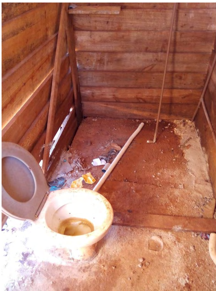
Figura 7 – Banheiro no canteiro de obras. Fonte: Autoria própria (2015).
