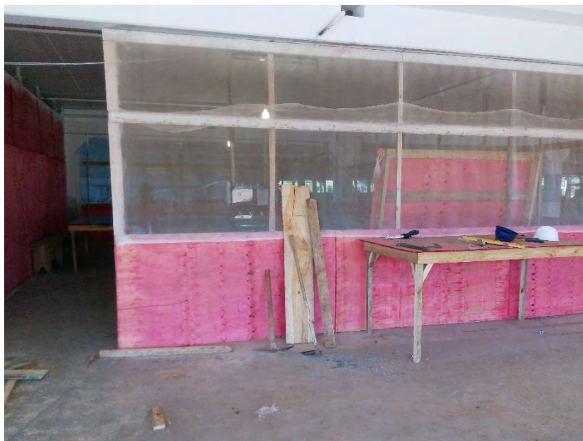
Figura 11 – Áreas de vivência junto à obra concluída. Fonte: Autoria própria (2015).
