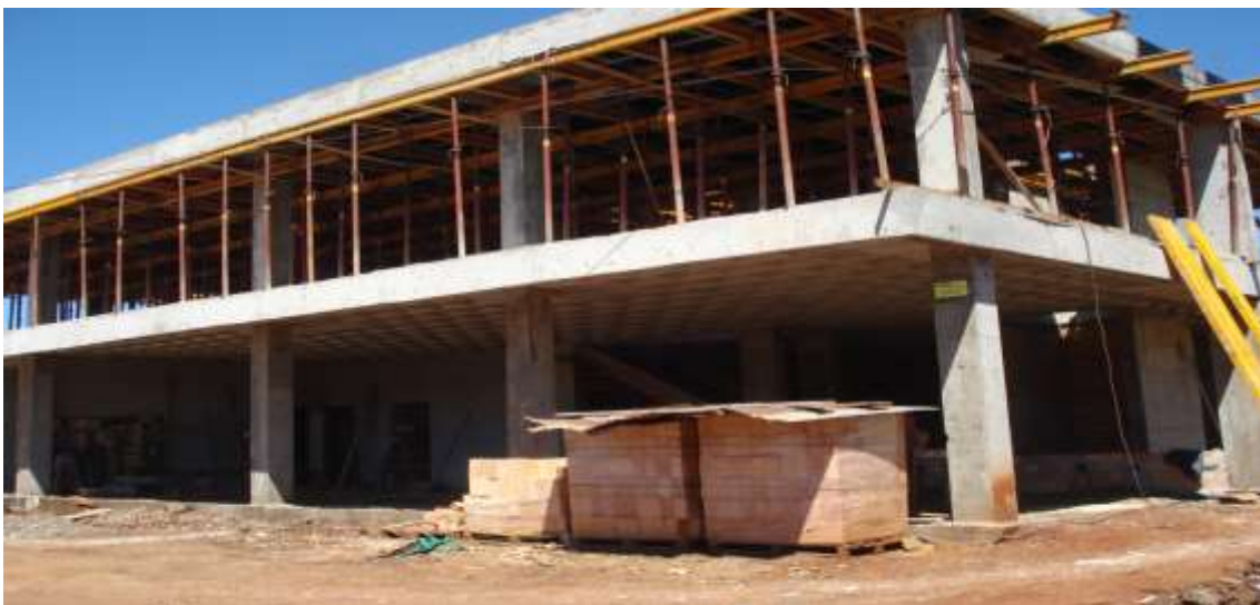
Figura 23: Obra realizada pela Empresa D. Fonte: Autoria própria (2014).
