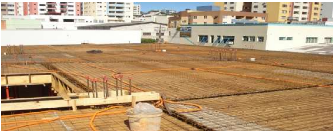
Figura 21: Obra realizada pela Empresa B. Fonte: Autoria própria (2014).
