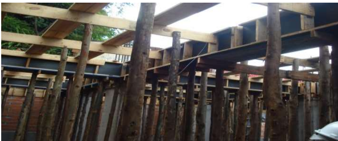
Figura 4: Sistema de fôrmas e escoramentos realizadas em Pato Branco - PR. Fonte: Autoria própria (2014).
