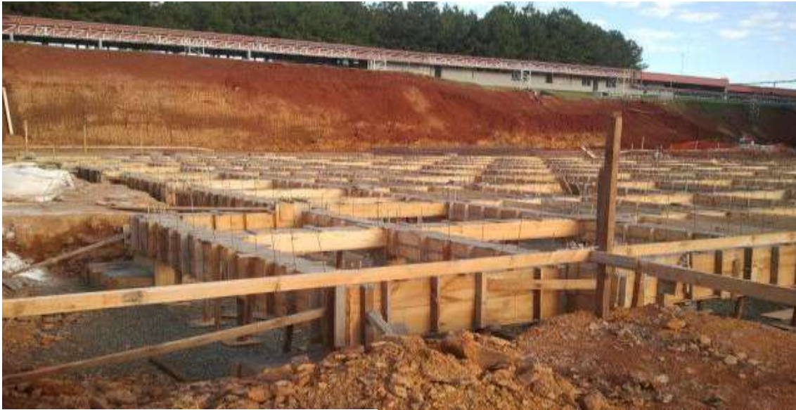
Figura 22: Obra realizada pela Empresa C. Fonte: Autoria própria (2015).
