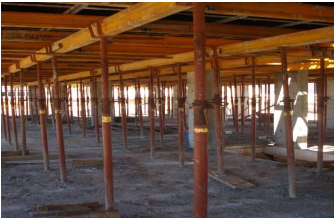
Figura 34: Exemplo de sistema de fôrma e escoramento para laje Nervurada. Fonte: Autoria própria 2014.
