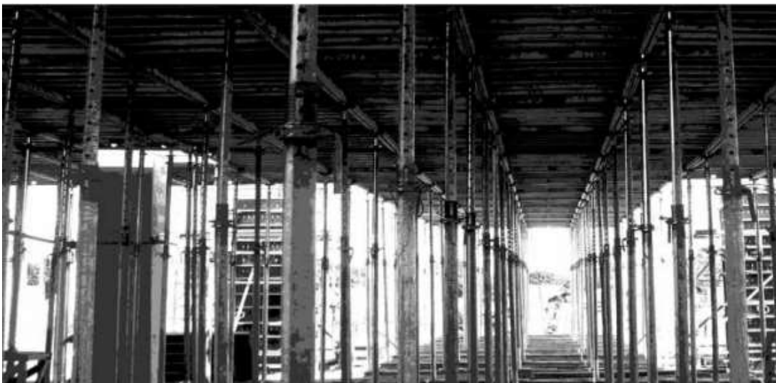
Figura 16: Sistema de fôrma metálica para laje. Fonte: SH (2008)
