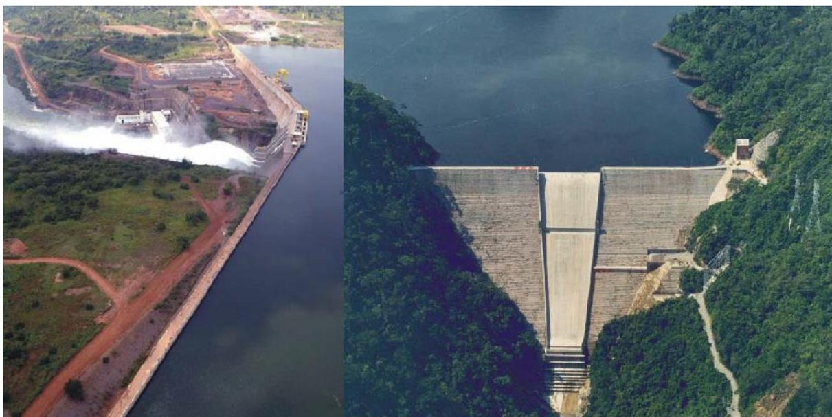
**Figura 4 - Barragem com seção tipo gravidade.**
