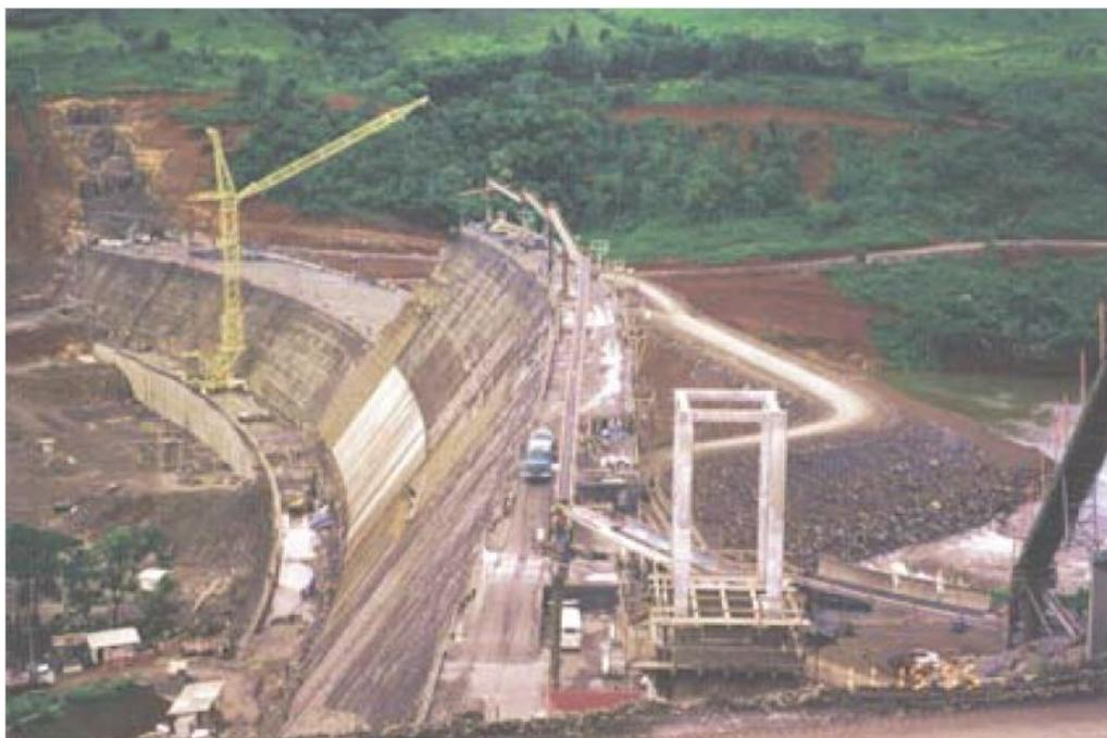
**Figura 5 - Barragem CCR em construção.**
