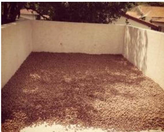
**Figura 6. Aplicação da argila expandida**
