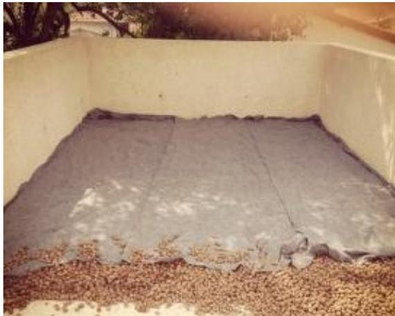
**Figura 7. Aplicação da manta geotêxtil**
