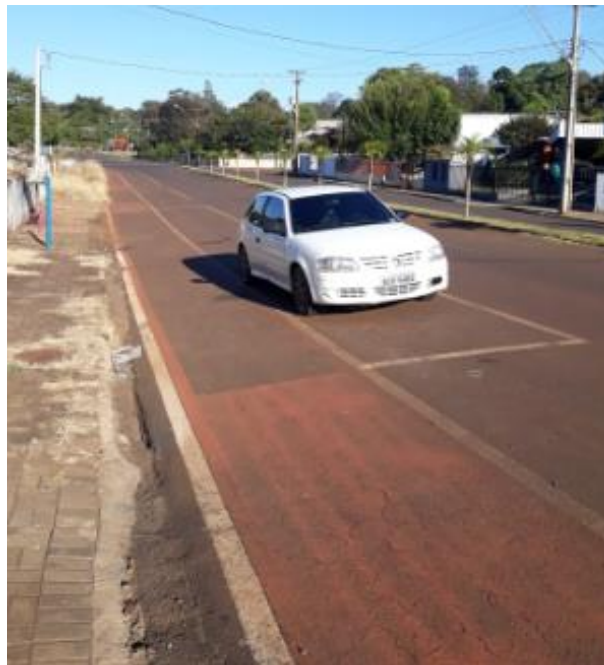
Figura 13: Ciclofaixa Rua Luís Parzianelo Fonte: Autoria própria
