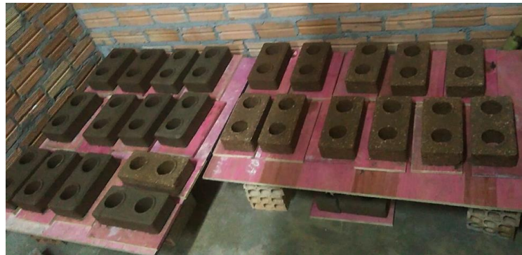
Figura 33 - Blocos de solo-cimento moldados e colocados para curar
