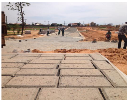
Figura 1 - Pavimento com solo-cimento Fonte: Cimento Montes Claros (2017).
