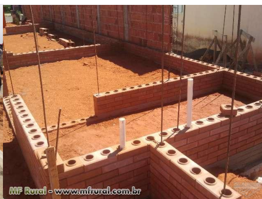
Figura 2 - Construção com blocos de solo-cimento Fonte: MF Rural (2012).
