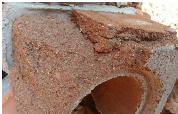
Figura 53 - Detalhe da parte rompida do bloco corrigido com areia
