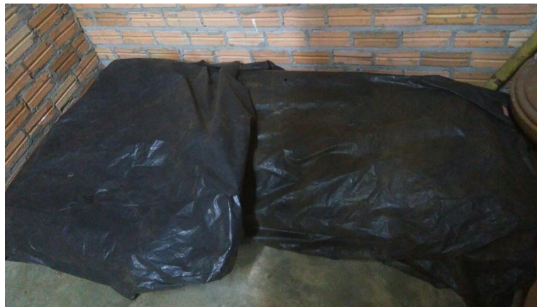
Figura 34 - Blocos cobertos com lona para preservar a umidade
