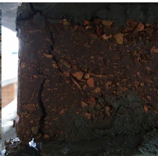
Figura 50 - Detalhe da fratura no bloco com RCD
