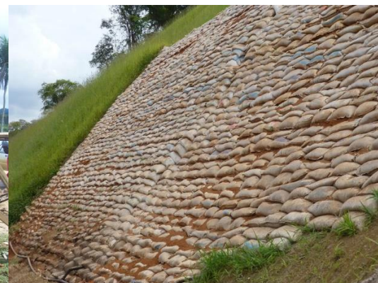
Figura 4 - Contenção de solo com solo-cimento Fonte: Cimento Montes Claros (2017).
