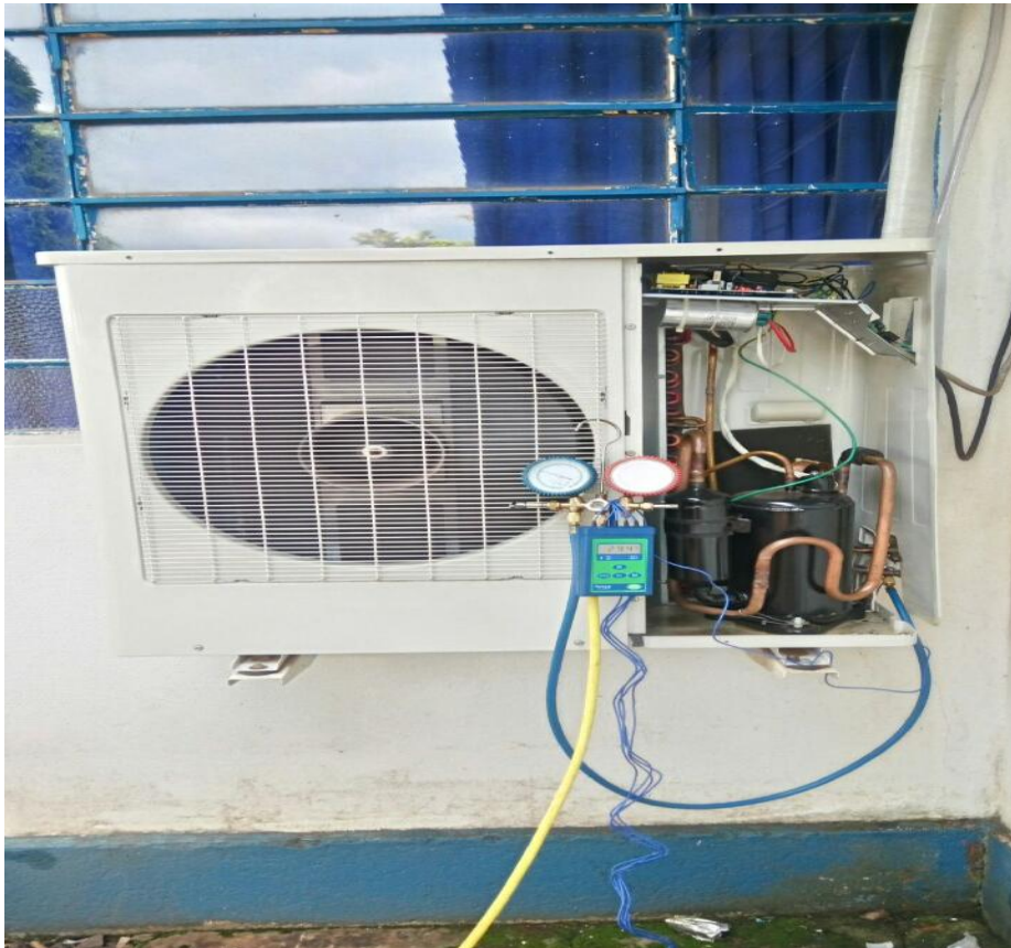
Figura 5: Retirada Fluido Refrigerante Fonte: Zimmermann Rafael e Quevedo Fabio
