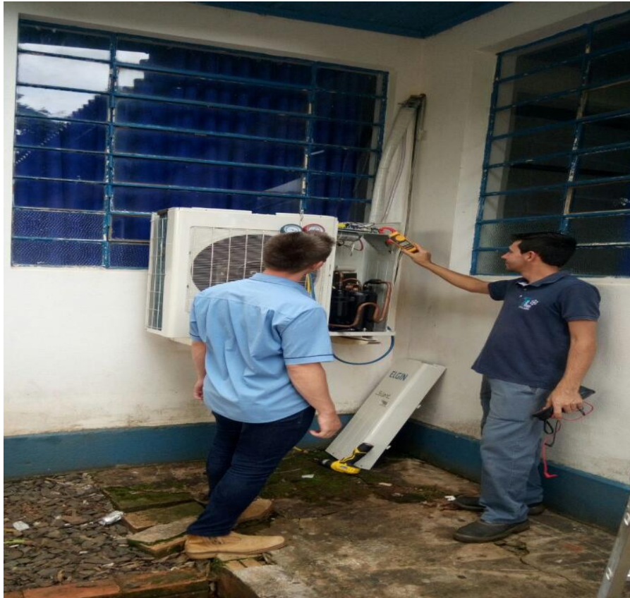
Figura 4: Medição de corrente e Tensão Fonte: Zimmermann Rafael e Quevedo Fabio
