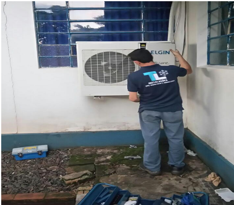
Figura 10: Reinstalando o condicionador de ar Fonte: Zimmermann Rafael e Quevedo Fabio
