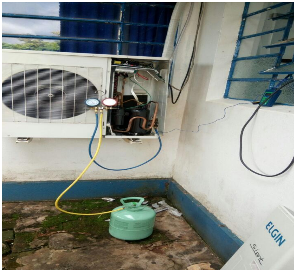
Figura 9: Recolocando Fluido Refrigerante Fonte: Zimmermann Rafael e Quevedo Fabio
