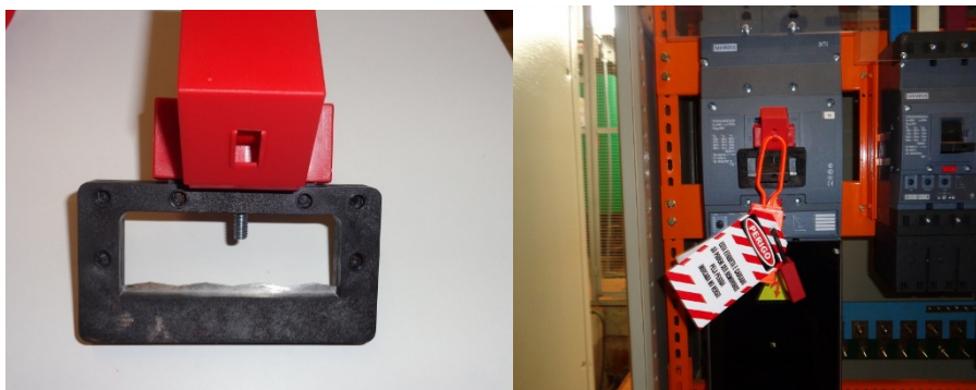
Figura 6: Bloqueio Para Manopla Do Disjuntor
