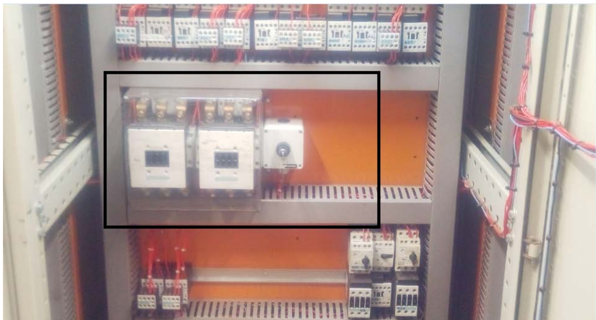
Figura 19: As contadoras e manopla responsável pela reversão do sentido de giro Fonte: própria.
