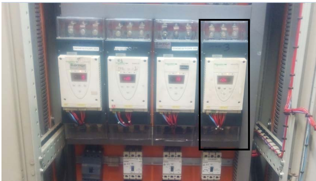
Figura 18: Soft Start do moinho de trituração Fonte: própria
