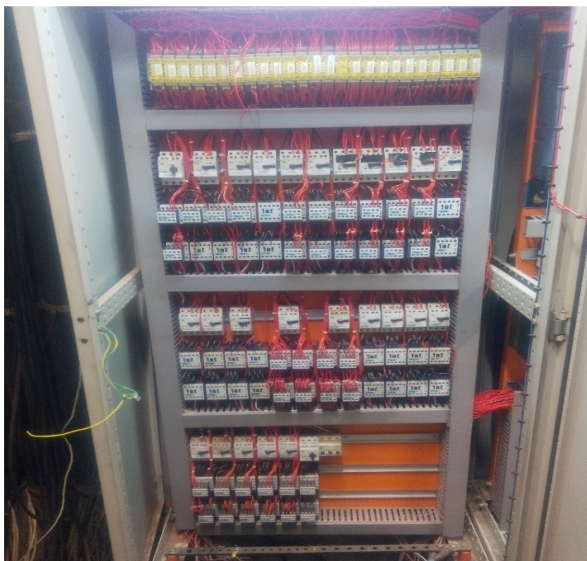
Figura 17: Painel 5 depois readequação Fonte: própria
