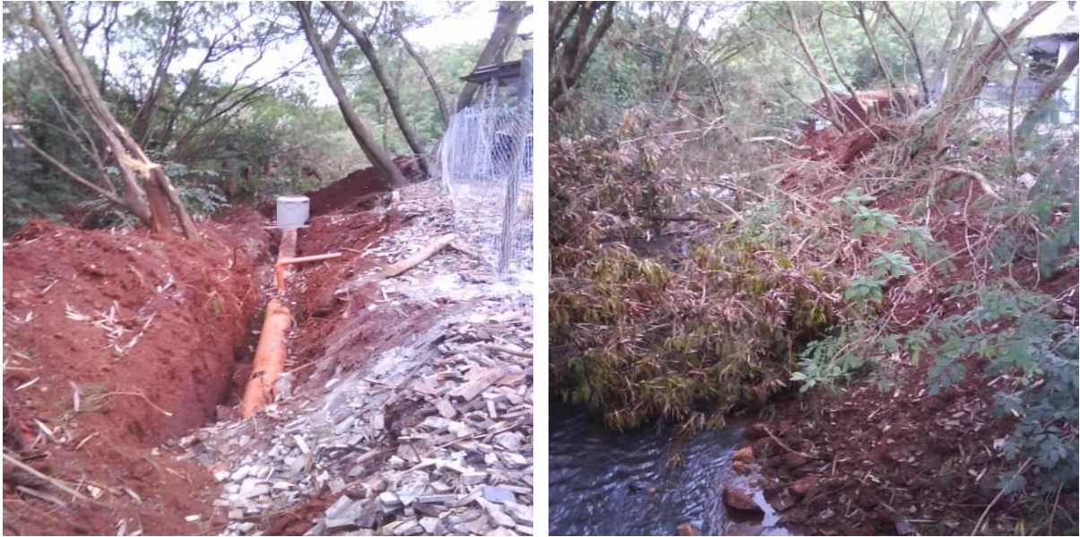
Figura 19 - Imagens das modificações do local, aplicação de tubulação de esgoto e derrubada de mata ciliar.
