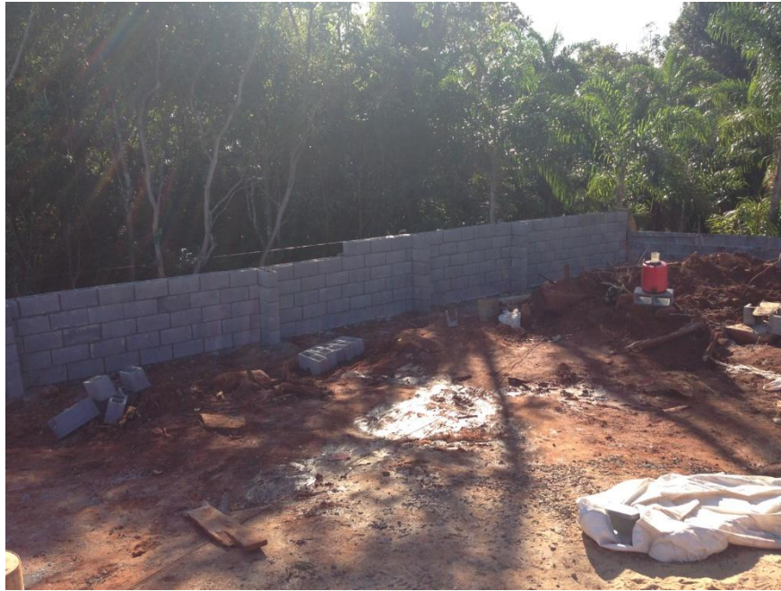
Figura 7- Distribuição do canteiro de obra da construção modular, 2016
