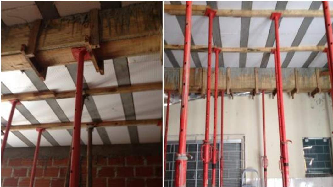
Figura 3: Madeiramento do sistema construtivo convencional, 2016.
