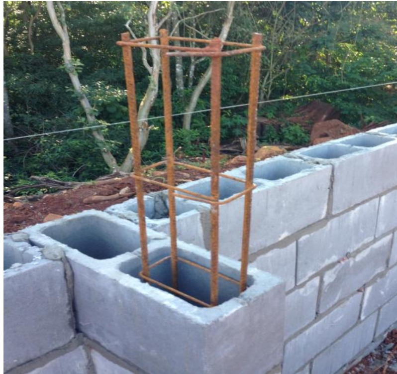
Figura 13- Armadura da construção estrutural, 2016
