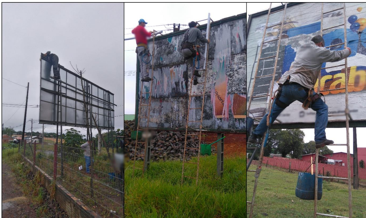
Figura 13 - Trabalho em altura na colagem de outdoor Fonte: Autoria própria.
